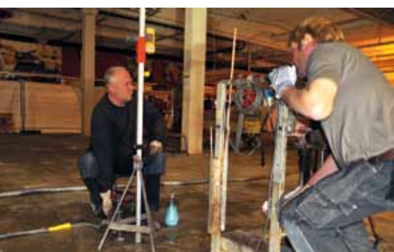
Över 12 000 hål borrades för att förstärka golvet på Coop Forum, Umeå.
