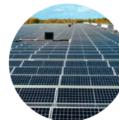
Stor takbyggd solcellsanläggning
