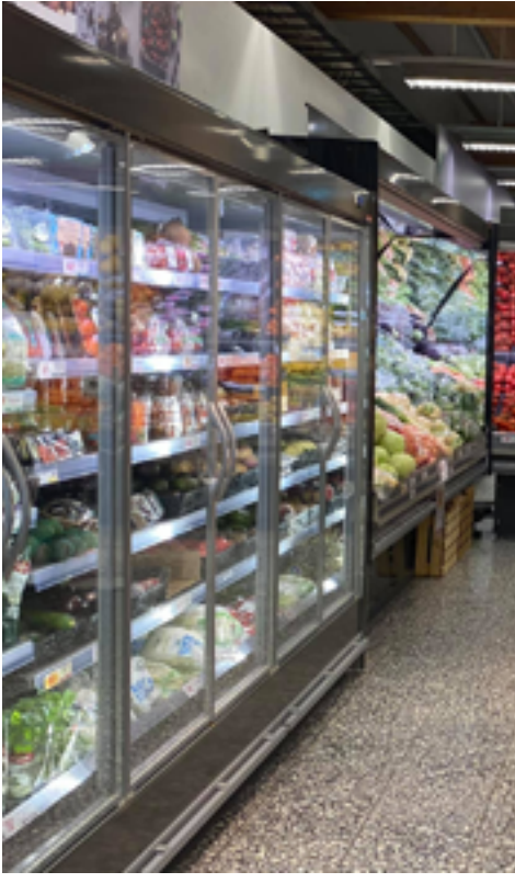
Coop Vännäs. Livsmedelskylan byttes, moderniserades och även ny ventilationsanläggning installerades.
